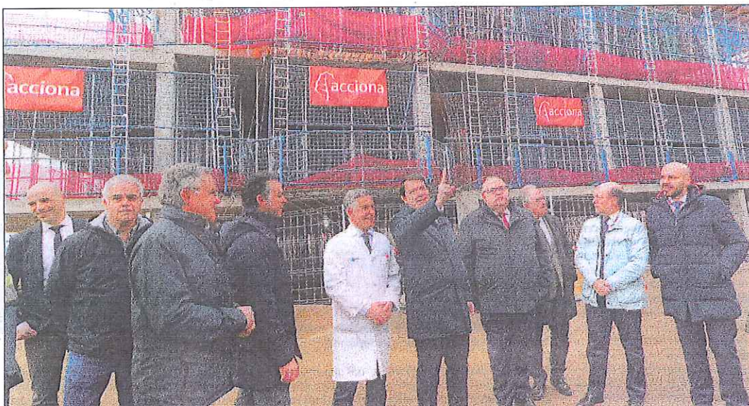
El presidente de la Junta visita las obras del nuevo bloque técnico del hospital de Palencia. ICAL
